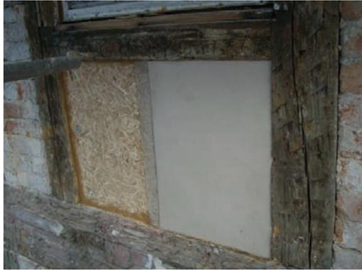
Ausfachung der Kommunwand mit Typha-Platten, Foto Helmut Knodt
