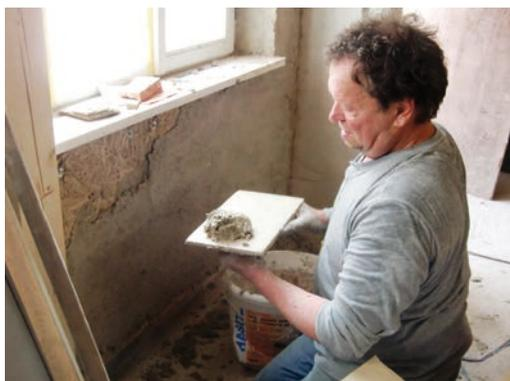
Sumpfkalk wurde dreifach aufgetragen. Auf diese Weise konnte die Wand von innen nach außen zunehmend diffusionsoffener hergestellt werden.
