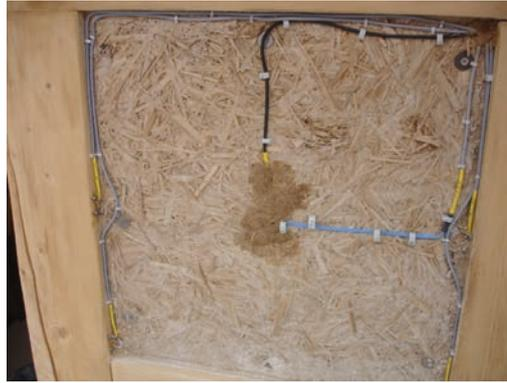
Bild 16: Äußere Sensorik an der Grenzschicht 1, unterhalb des Außenputzes, Foto IBP
