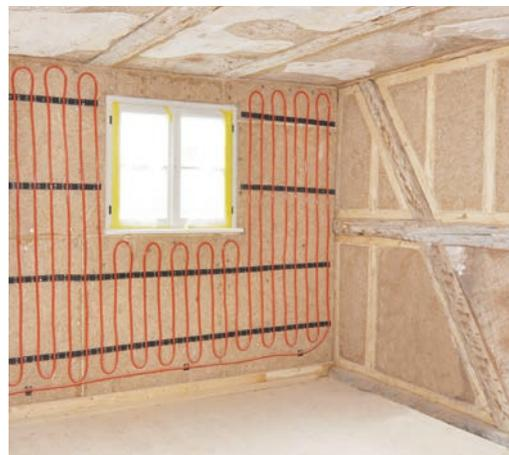
Belegen der Gesamfläche und Aufschrauben der Heizrohre, Architekturbüro Fritsch+Knodt&Klug
