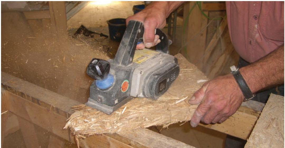
Einbau und Verschraubung der äußeren Typha-Platte mit Ausbildung einer Fuge zum Fachwerk, Foto Alexandra Fritsch
